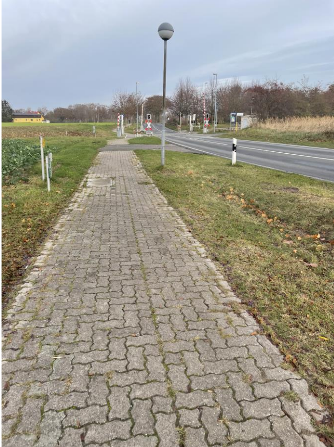
Foto 13: Station 0+810,00 Blickrichtung Bahnübergang
