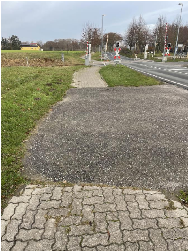
Foto 14: Blickrichtung Bahnübergang Station 0+830,00
