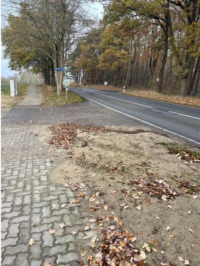
Foto 07: Station 0+200,00 Einmündung Zinnowitzer Straße
