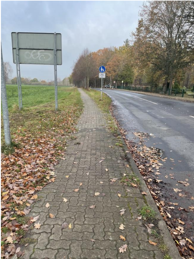
Foto 03: Einmündungsbereich B111 in Baurichtung
