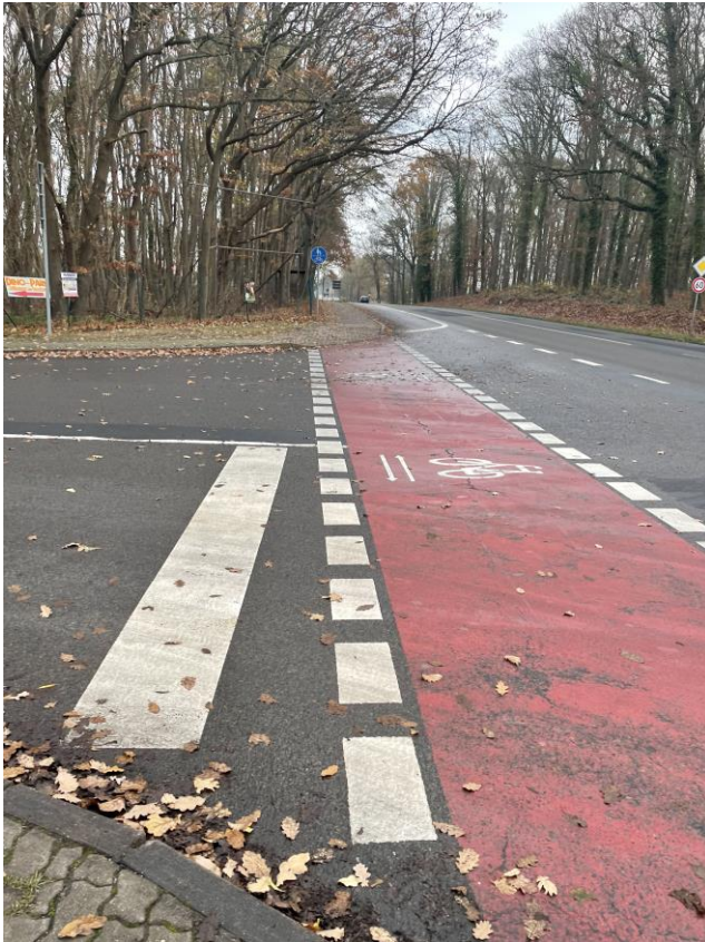
Foto 01: Baubeginn, Anschluss an die B111
