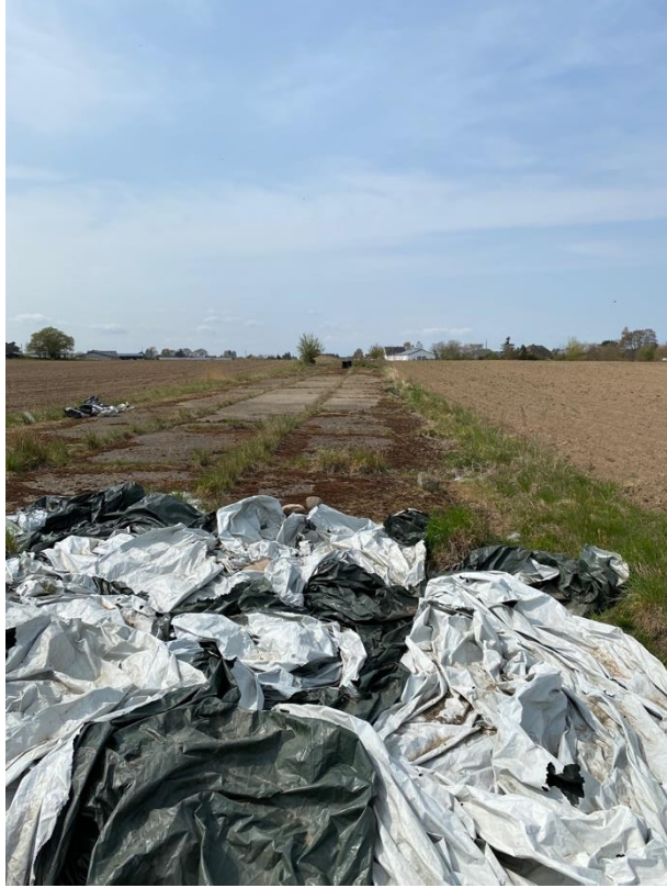
versiegelte ehem. Landebahn, Blick von Osten
