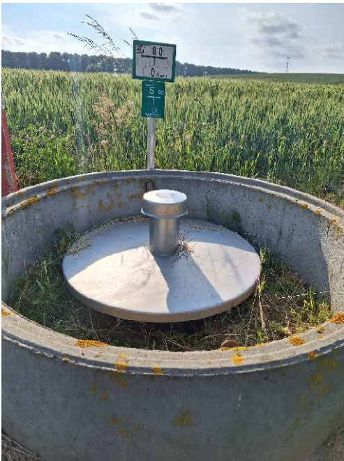
Bild 21: vorh. Schmutzwasserschacht
