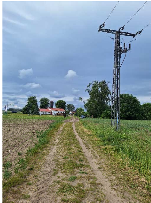
Bild 17: Blick in Richtung Bannemin/ Bauende
