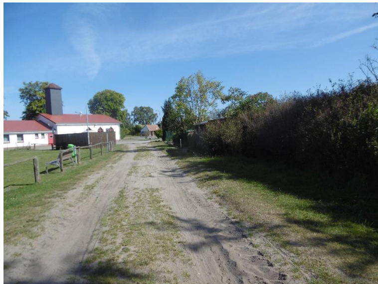
Foto 7: In der Ortslage Bannemin ist der Weg unbefestigt. Der Wegeausbau erfolgt in der derzeitigen Trasse, abweichend vom Wegeflurstück.
