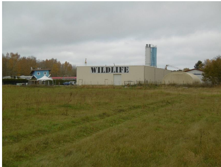
Foto 1: Bestandssituation nördlich des geplanten Gewerbegebietes. Hier sind durch die touristischen Anlagen, Gebäude und Baulichkeiten des Frischbeton-Werkes Vorprägungen und Beeinträchtigungen des Landschaftsraumes gegeben.
