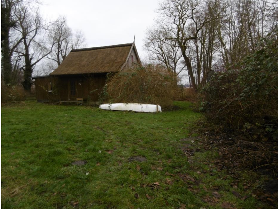
Foto 3: Das Ergänzungsgebiet 2 ist mit einem Wohngebäude bebaut. Die Freiflächen sind mit Rasenvegetationen und Sträuchern begrünt. Randständig haben sich Brombeergebüsche ausgebreitet.
