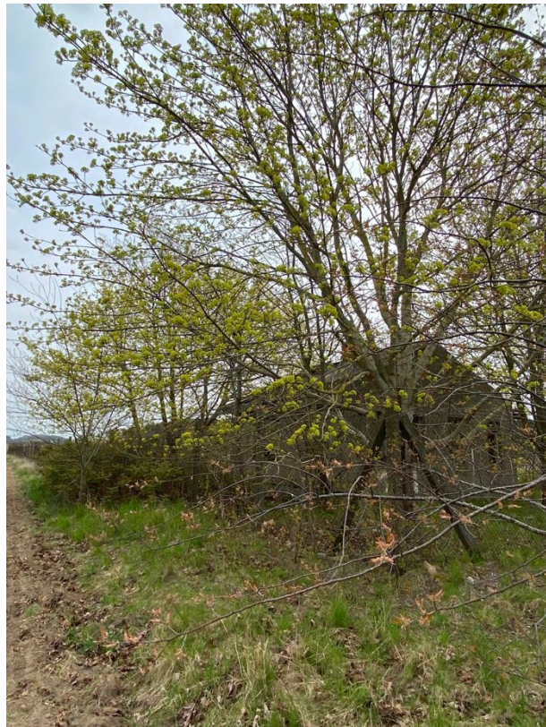
Blick von Westen ehemalige Produktionsstätte, verbuschend
