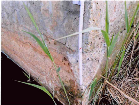
0001M_H2024_ABPLATZUNG_WIDERLAGER NORD
