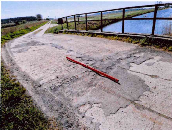
0001M_H2024_BETONBELAG GERISSEN
