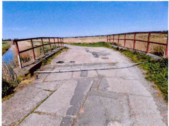
0001M_H2024_FUGEN KAPPE_FAHRBAHN_BEIDSEITIG BEWACHSEN
