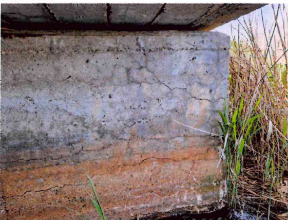
0001M_H2024_NETZRISSE_WIDERLAGER NORD
