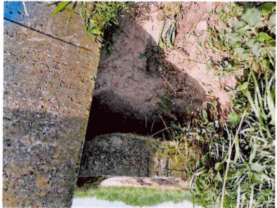
0001M_H2024_SCHLEPPPLATTE NORDSEITE HOHLLIEGEND
