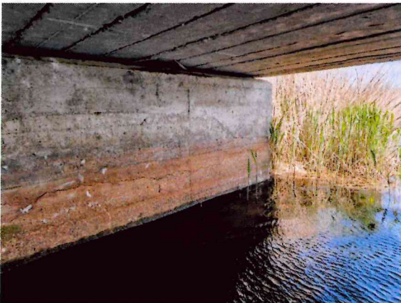
0001M_H2024_HORIZONTALRISS_WIDERLAGER NORD
